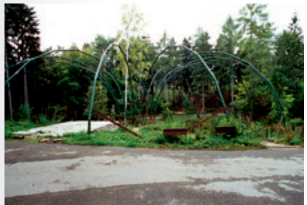
Stavba nové konstrukce obří voliéry
